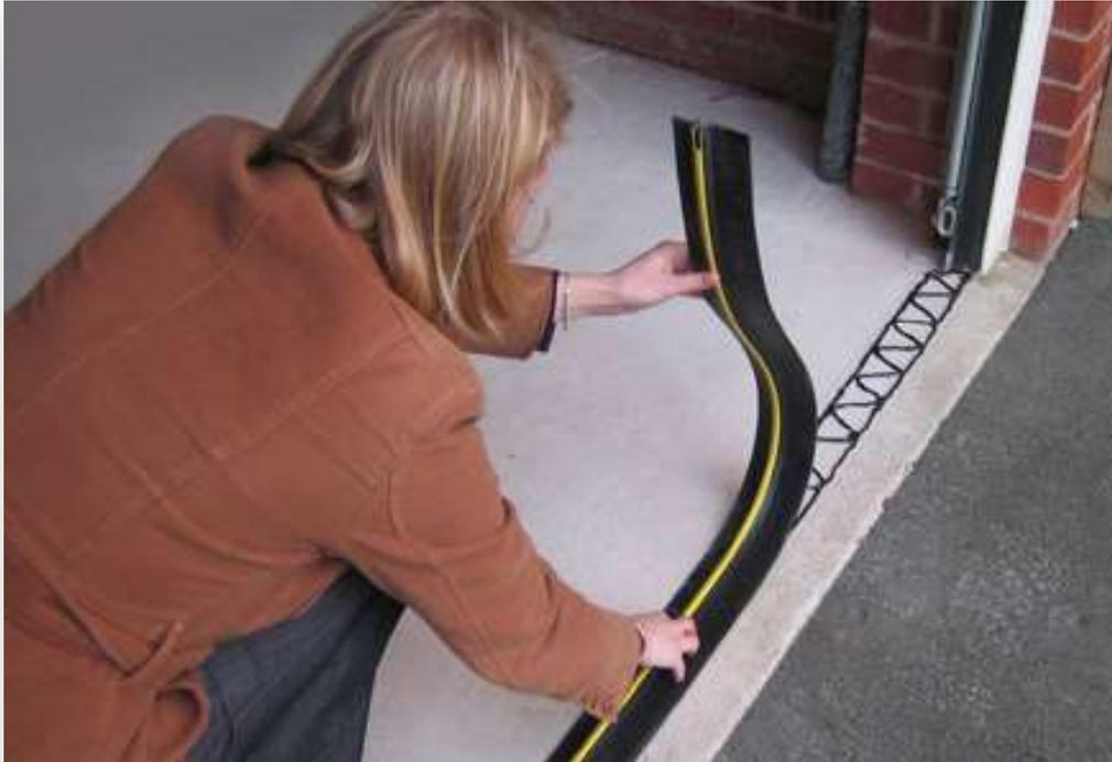
En commençant d'une extrémité, placer le joint de seuil sur le mastic, en appuyant fermement. Continuer tout le long du joint, en veillant à maintenir un bon contact tout du long. Avec un chiffon propre, essuyer l'excédent de mastic des deux côtés du joint. Laisser sécher 24 heures avant de rouler sur le joint de seuil.
