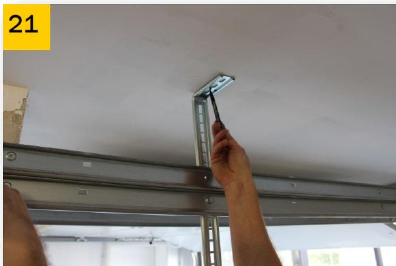
Il est impératif que les rails horizontaux soient parfaitement parallèles entre eux et parfaitement de niveau. Pour ce faire, mesurer les diagonales de vos rails (Photos 22) .
