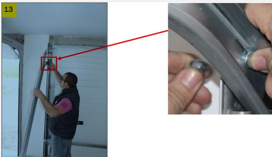
Relever le rail horizontal et passer le haut du rail dans la roulette haute avant de le boulonner (Photo 14).
